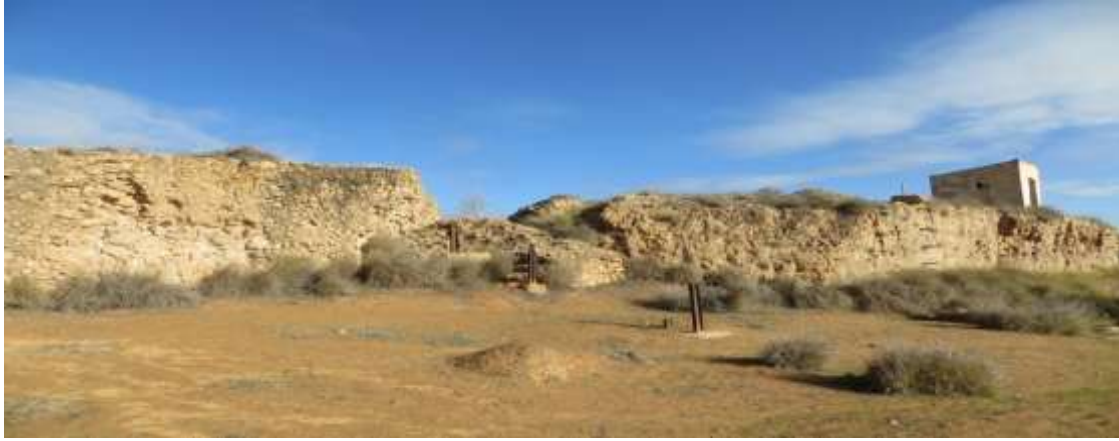
شكل 7 : السد ZLN38 سد توجيهي شيد علي الرافد الغربي للوادي . المصدر تصوير الباحث
