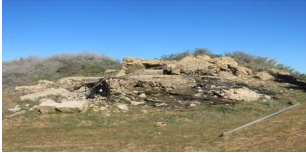
شكل 10 : ZLN33 أساسات جدارية لمبنى مرتبط بالسد وقناة المياه .المصدر تصوير الباحث
