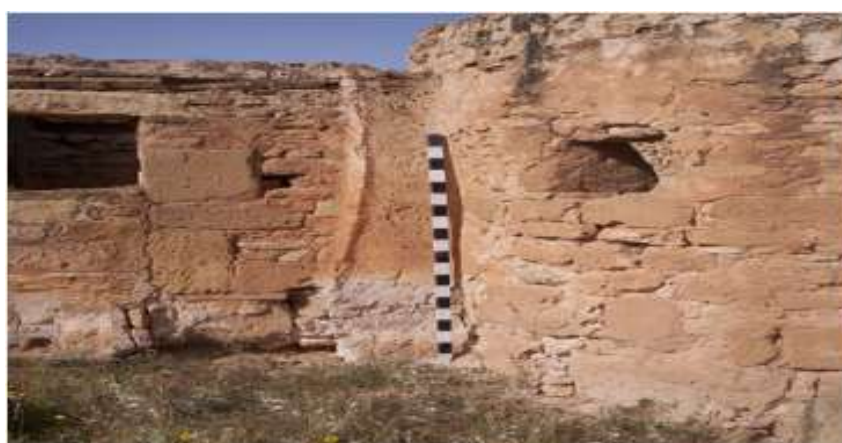
(الصورة "12" ) تصريف مياه الأمطار بواسطة مزاريب مشبته عبر الجدران
