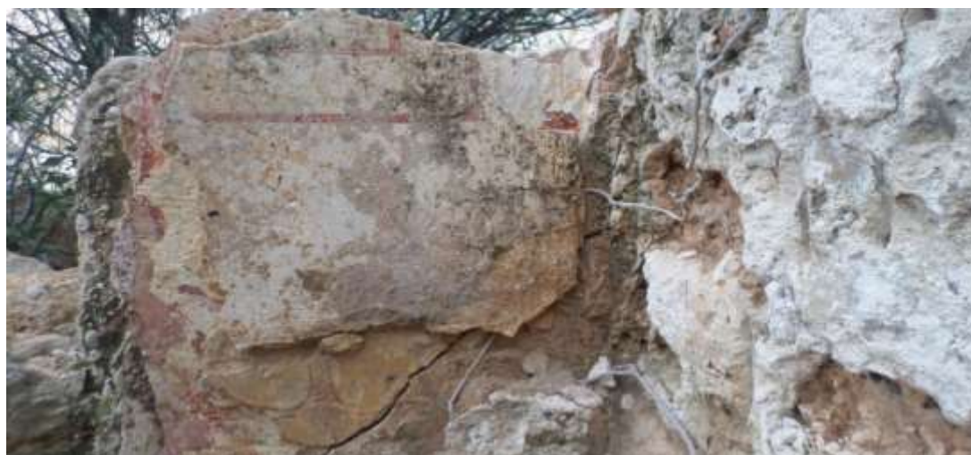
(الصورة "8" ) طبقات من الملاط المدكوك والبلاستر تزينها رسومات هندسية ونباتية باللون الأحمر
