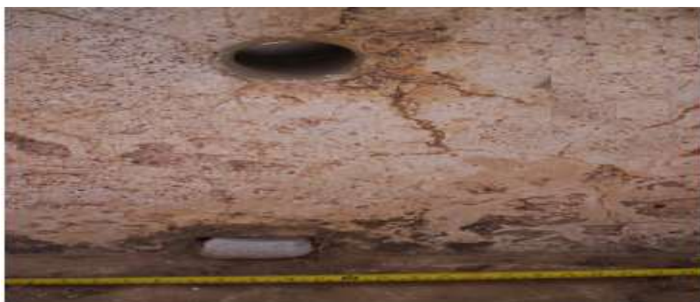
(الصورة "10" ) أغلاق القناة السفلى، وتحويل تدفق المياه عبر القناة العليا
